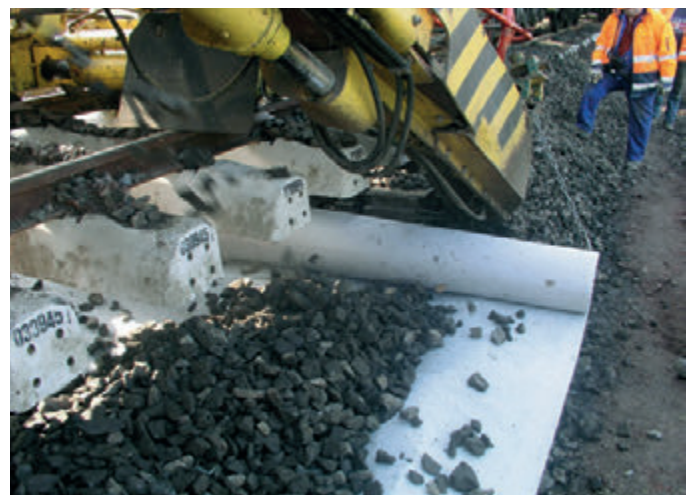
Abb. 7: Erprobungsstelle Bf Götzenhof (nordöstlich von Fulda, Hessen) – gleisegebundener maschineller Einbau mit einer Schotterbettreinigungsmaschine eines mechanisch verfestigten und zusätzlich chemisch stabilisierten Endlosfaservlieses mit einem Flächengewicht von knapp 650 g/m 2
