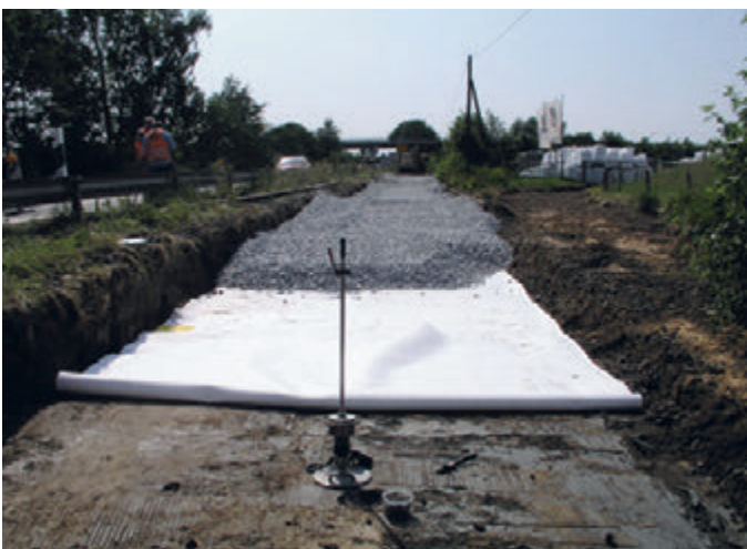
Abb. 6: Erprobungsbaustelle Wittmund (nordwestlich von Wilhelmshaven, Niedersachsen) – gleisfreier manueller Einbau eines mechanisch verfestigten Stapelfaservlieses mit einem Flächengewicht von ca. 800 g/m 2
