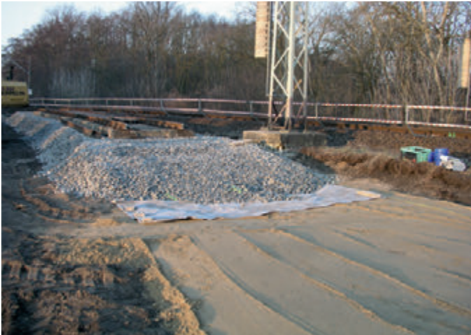
Abb. 4: Großversuch Eisenhüttenstadt – Lage des Geokunststoffes in der Ebene des Planums mit direkter Schotterauflage
